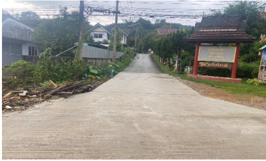
ก่อสร้างถนนคอนกรีตเสริมเหล็กเชื่อมถนนสายหลัก บ้านปางกอก หมู่ที่ 9 (จุดที่ 4) ซอย 9
