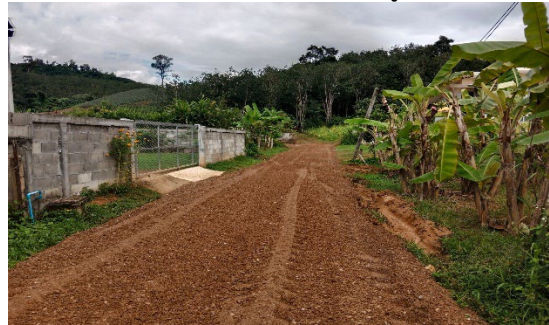
โครงการซ่อมแซมด้วยการลงหินคลุก ซอย 11 บ้านปางริมกรณ์ หมู่ที่ 10
