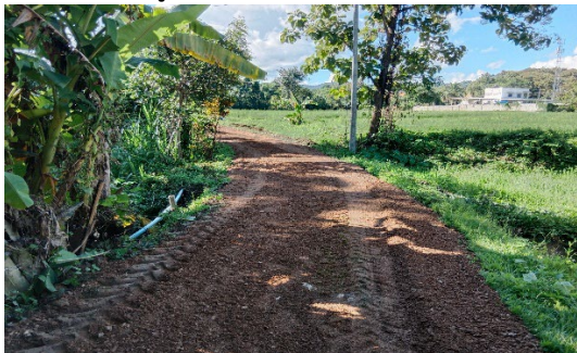
โครงการซ่อมแซมถนนด้วยการลงหินคลุก บ้านใหม่ หมู่ที่ 8
