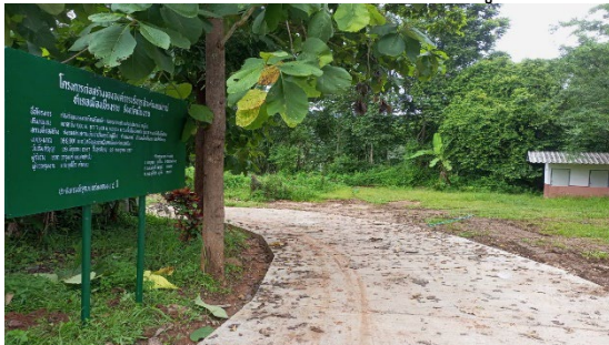
โครงการก่อสร้างถนนคอนกรีตเสริมเหล็ก ซอยผาณสถาน บ้านปางริมกรณ์ หมู่ที่ 10
