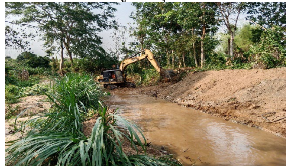
โครงการงานซ่อมแซมตลิ่งลำน้ำกรณ์ บ้านเมืองรวง หมู่ที่ 5 จุดที่ 4
