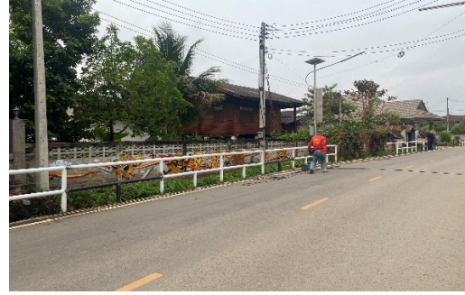
โครงการก่อสร้างรางกั้นลำเหมือง บ้านเมืองรวง หมู่ที่ 5
