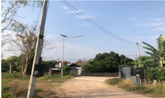
โครงการติดตั้งโคมไฟถนนโซล่าเซลล์ ภายในหมู่บ้าน บ้านสวนดอก หมู่ที่ 3
