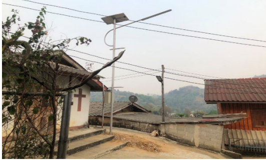
โครงการติดตั้งโคมไฟถนนโซล่าเซลล์ ภายในหมู่บ้าน บ้านปางริมกรณ์ หมู่ที่ 10
