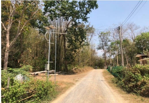
โครงการติดตั้งโคมไฟถนนโซล่าเซลล์ ภายในหมู่บ้าน บ้านป่าสักทอง หมู่ที่ 13
