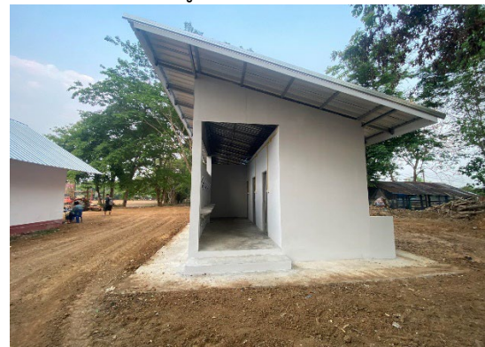
โครงการก่อสร้างห้องน้ำสาธารณะ บ้านเวียงหวาย หมู่ที่ 2
