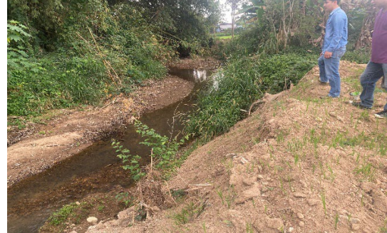
โครงการงานซ่อมแซมตลิ่งลำน้ำกรณ์ บ้านเมืองรวง หมู่ที่ 5 จุดที่ 2
