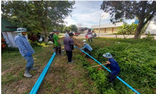
โครงการขยายเขตระบบประปาหมู่บ้าน บ้านใหม่ หมู่ที่ 8
