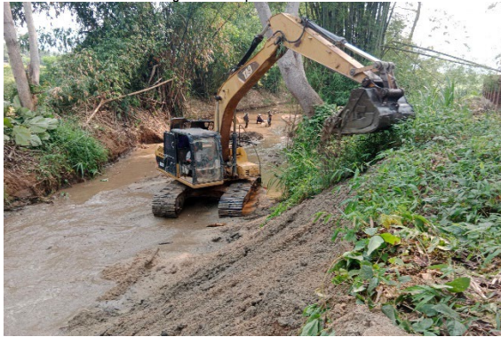
โครงการงานซ่อมแซมตลิ่งลำน้ำกรณ บ้านเมืองรวง หมู่ที่ 5 จุดที่ 5
