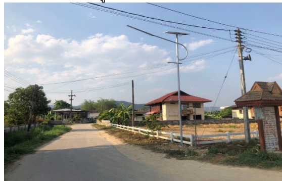
โครงการติดตั้งโคมไฟถนนโซล่าเซลล์ ภายในหมู่บ้าน บ้านฝางหมื่น หมู่ที่ 7
