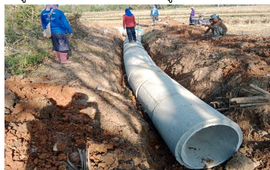
โครงการขุดลอกลำเหมืองพร้อมวางท่อ ระบายน้ำ คสล.ซอย 6 บ้านเมืองรวง หมู่ที่ 5 ถึงบ้านป่าสักทอง หมู่ที่ 13
