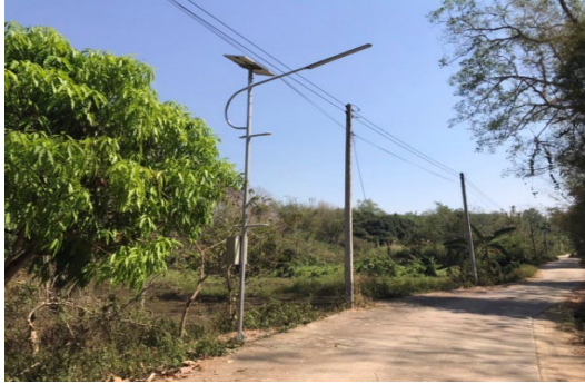
โครงการติดตั้งโคมไฟถนนโซล่าเซลล์ ภายในหมู่บ้าน บ้านใหม่ หมู่ที่ 8
