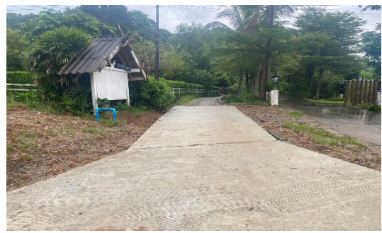
ก่อสร้างถนนคอนกรีตเสริมเหล็กเชื่อมถนนสายหลัก บ้านปางกอก หมู่ที่ 9 (จุดที่ 5) ซอย 11
