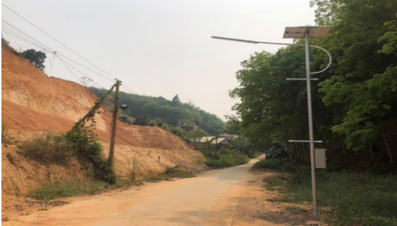
โครงการติดตั้งโคมไฟถนนโซล่าเซลล์ ภายในหมู่บ้าน บ้านปางป่าอ้อ หมู่ที่ 11
