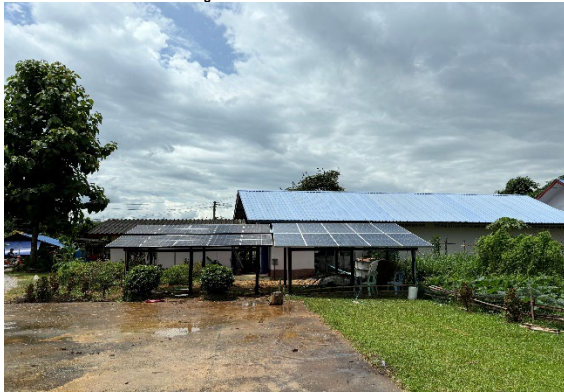
โครงการก่อสร้างระบบผลิตไฟฟ้าพลังงานแสงอาทิตย์ บ้านเวียงหวาย หมู่ที่ 2
