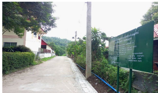
โครงการก่อสร้างรางระบายน้ำคอนกรีต เสริมเหล็กรูปตัวยูพร้อมฝารางคอนกรีต เสริมเหล็ก ซอย 9 บ้านปางกอก หมู่ที่ 9
