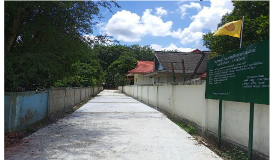
โครงการก่อสร้างถนนคอนกรีตเสริมเหล็ก ซอยข้างวัดฝิ่งหมื่น บ้านฝิ่งหมื่น หมู่ที่ 7
