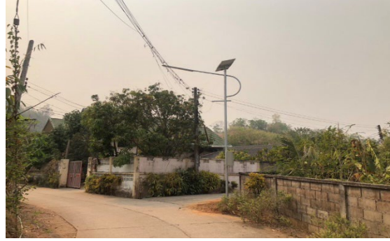
โครงการติดตั้งโคมไฟถนนโซล่าเซลล์ ภายในหมู่บ้าน บ้านปางกอก หมู่ที่ 9
