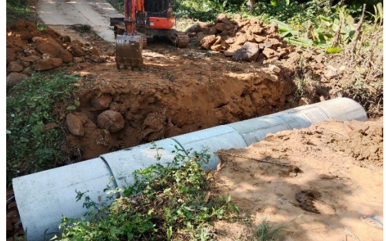
โครงการซ่อมแซมถนนด้วยการวางท่อ คสล. พร้อมซ่อมแซม ซอย 8 บ้านปางริมกรณ์ หมู่ที่ 10
