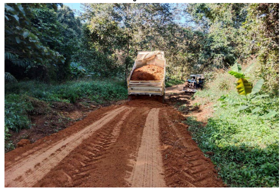
โครงการงานซ่อมแซมถนนด้วยการถมดิน บ้านหนองเขี้ยว หมู่ที่ 12
