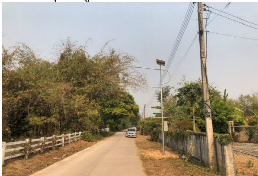
โครงการติดตั้งโคมไฟถนนโซล่าเซลล์ ภายในหมู่บ้าน บ้านปางม้ง หมู่ที่ 6
