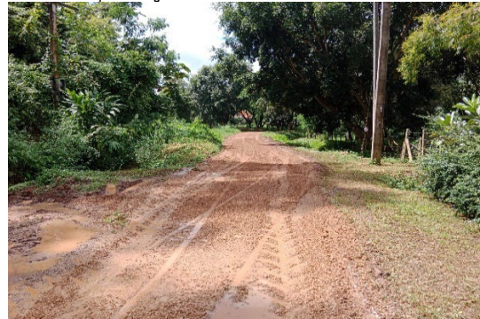
โครงการซ่อมแซมถนนด้วยการลงหินคลุก บ้านปางมั่ง หมู่ที่ 6
