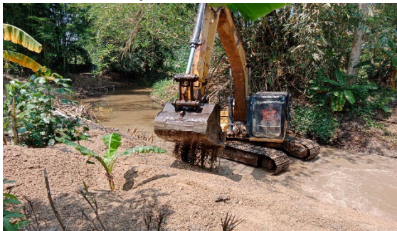
โครงการงานซ่อมแซมตลิ่งลำน้ำกรณ์ บ้านเมืองรวง หมู่ที่ 5 จุดที่ 3
