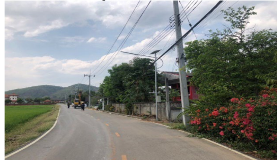
โครงการติดตั้งโคมไฟถนนโซล่าเซลล์ ภายในหมู่บ้าน บ้านแม่สาด หมู่ที่ 4
