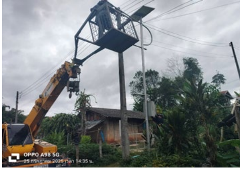
โครงการจ้างซ่อมเสาไฟฟ้าพลังงานแสงอาทิตย์ บ้านปางริมกรณ์ หมู่ที่ 10
