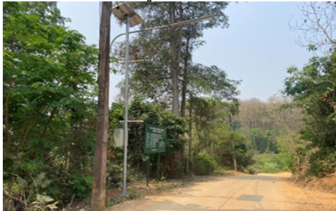
โครงการติดตั้งโคมไฟถนนโซล่าเซลล์ภายในหมู่บ้าน บ้านหนองเขียว หมู่ที่ 12
