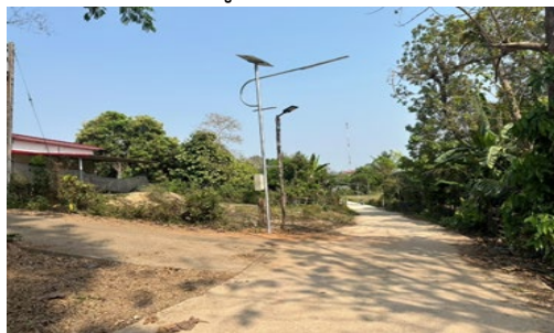
โครงการติดตั้งโคมไฟถนนโซล่าเซลล์ภายในหมู่บ้าน บ้านป่าสักทอง หมู่ที่ 13
