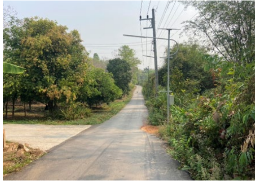
โครงการติดตั้งโคมไฟถนนโซล่าเซลล์ภายในหมู่บ้าน บ้านฝางหมื่น หมู่ที่ 7
