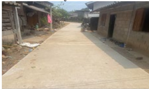
โครงการถนนคอนกรีตเสริมเหล็ก ซอยบ้านนางลูหมี่ จะทอ บ้านหนองเขี้ยว หมู่ที่ 12
