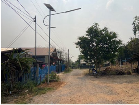
โครงการติดตั้งโคมไฟถนนโซล่าเซลล์ภายในหมู่บ้าน บ้านปางม้ง หมู่ที่ 6
