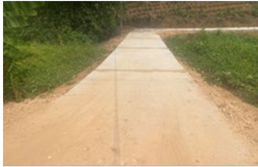
โครงการถนนคอนกรีตเสริมเหล็ก ซอยลานอเนกประสงค์ ปีกบ้านใหม่ บ้านหนองเขี้ยว หมู่ที่ 12
