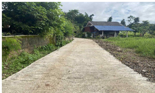
โครงการถนนคอนกรีตเสริมเหล็ก ซอยบ้านนายทองสุข ศรีกัลยา บ้านป่าสักทอง หมู่ที่ 13
