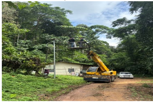
โครงการจ้างซ่อมเสาไฟฟ้าพลังงานแสงอาทิตย์ บ้านปางป่าอ้อ หมู่ที่ 11
