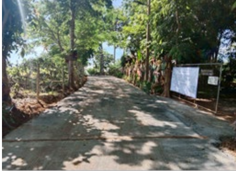
โครงการถนนคอนกรีตเสริมเหล็ก ซอยบ้านนายประวิง จันทรา บ้านป่าสักทอง หมู่ที่ 13
