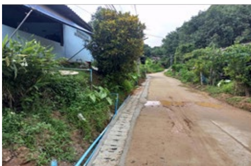
โครงการก่อสร้างวางระบายน้ำ คสล. รูปตัวยูพร้อมฝาปิด ซอย 3 บ้านปางป่าอ้อ หมู่ที่ 11
