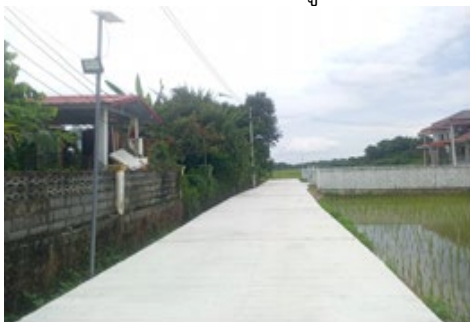
โครงการก่อสร้างถนนคอนกรีตเสริมเหล็ก ซอยร่วมใจ บ้านฝางหมื่น หมู่ที่ 7
