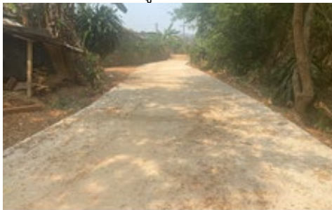
โครงการถนนคอนกรีตเสริมเหล็ก ซอยบ้านนายเกษม แสนใหม่ บ้านหนองเขี้ยว หมู่ที่ 12
