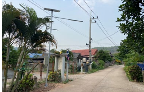
โครงการติดตั้งโคมไฟถนนโซล่าเซลล์ภายในหมู่บ้าน บ้านปางริมกรณ์ หมู่ที่ 10
