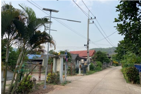
โครงการติดตั้งโคมไฟถนนโซล่าเซลล์ภายในหมู่บ้าน บ้านปางกอก หมู่ที่ 9
