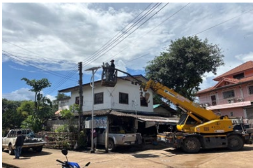
โครงการจ้างซ่อมเสาไฟฟ้าพลังงานแสงอาทิตย์ บ้านหนองเขียว หมู่ที่ 12
