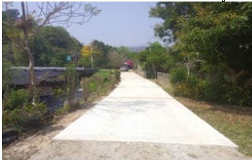
โครงการก่อสร้างถนนคอนกรีตเสริมเหล็ก ซอยข้างลำน้ำกรณ บ้านปางริมกรณ์ หมู่ที่ 10
